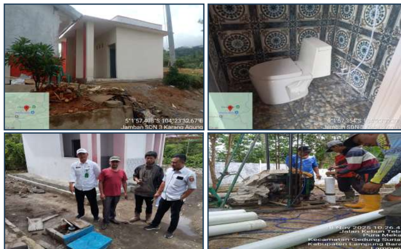
Gambar 4.1. Pembangunan Sumur Bor dan Toilet/Jamban Sekolah
