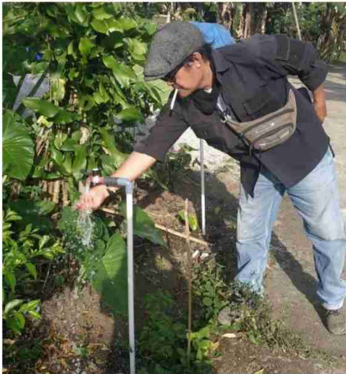
Gambar 4.18 Sambungan Rumah (SR) di Pekon Gedung Surian, Gedung Surian
